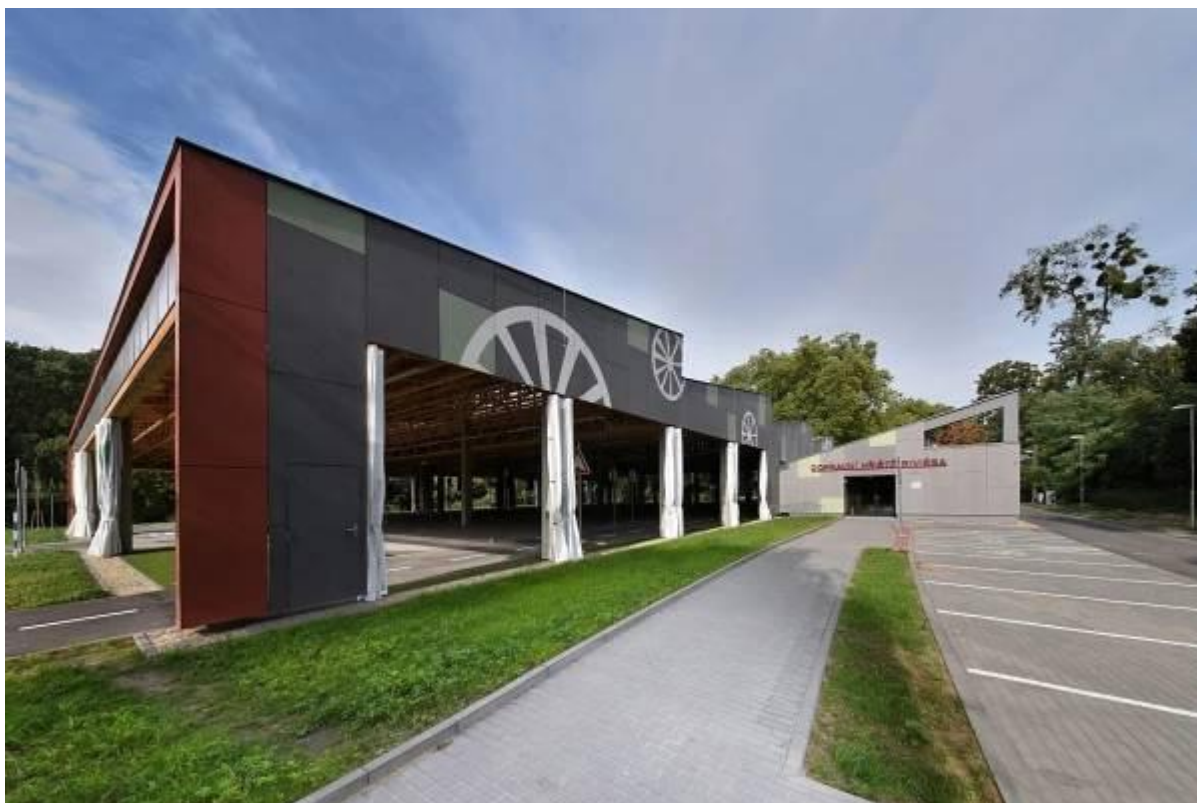
HALA DOPRAVNÍHO HŘIŠTĚ - RIVIÉRA
