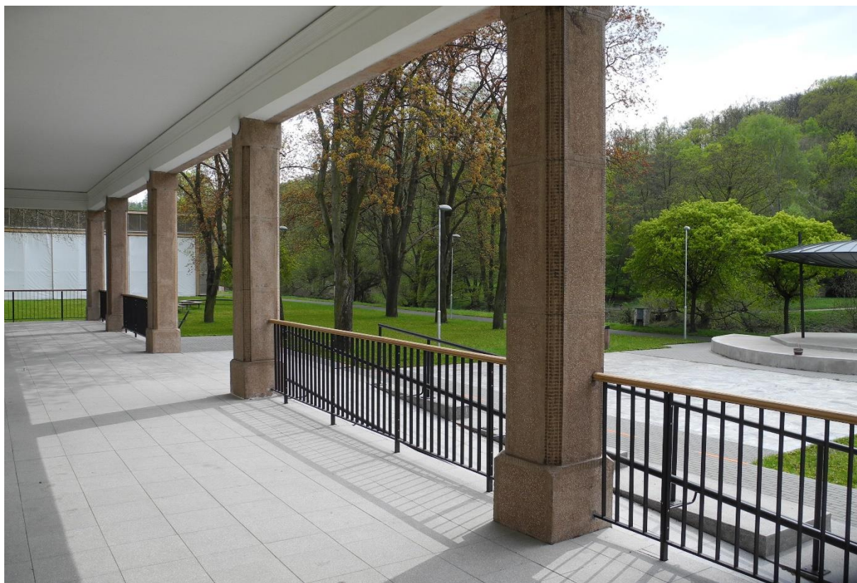
TERASA U PŘEDNÁŠKOVÉHO SÁLU V BUDOVĚ „ZÁMEČKU“
