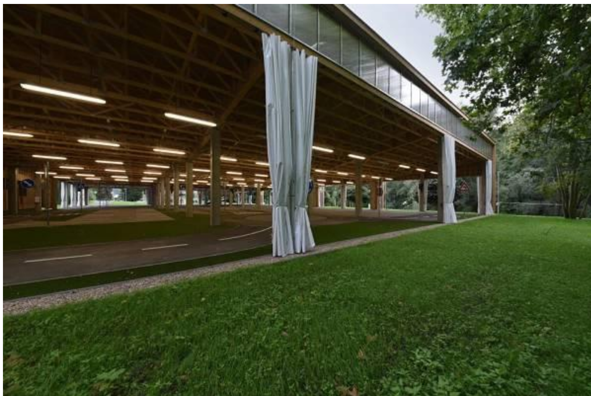
HALA DOPRAVNÍHO HŘIŠTĚ - RIVIÉRA
